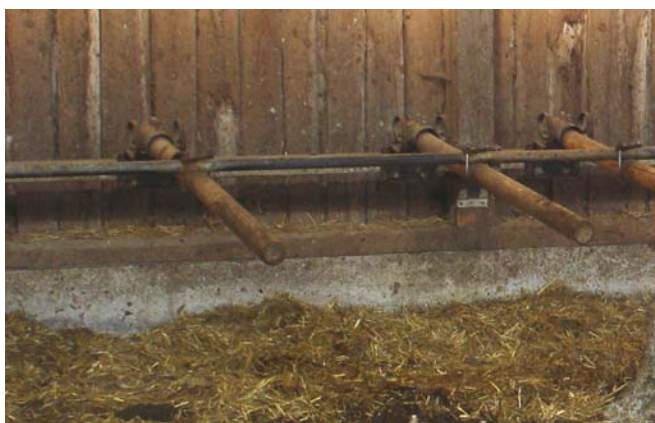
Abb. 2: Durch hängende Boxenabtrennungen können Unfälle vermieden werden.
